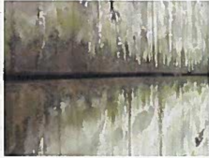
WL 1, STB 3, undicht mit Schlamm u. pumpt bis 1mm
