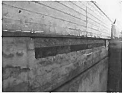
Übb. STB 3, Überdeckung der Walzträger gerissen, hohl u. abgeplatzt, Bild 1
