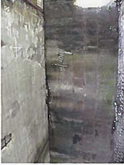
WL 1, STB 2, Auflagerbank OS, undicht mit Schlamm
