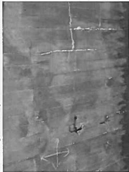
Übb. STB 3, Walzträger z.T. freilegend
