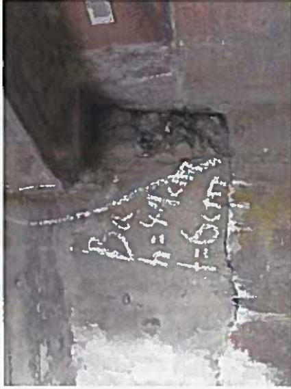
STB 2, Tragwerk pumpt bei Zugfahrt bis 3mm über WL 1+2
