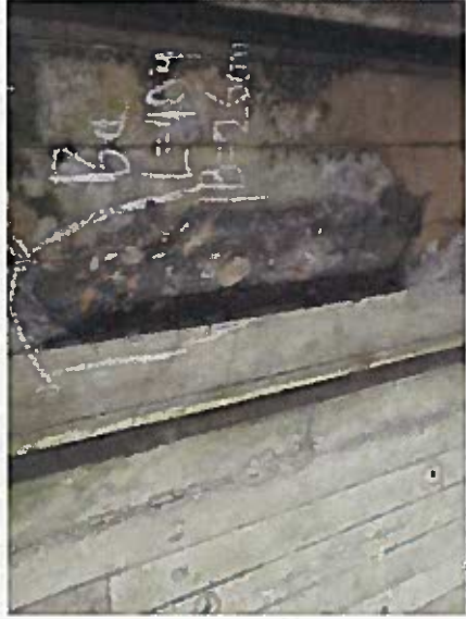
WL 2, STB 1, Flügel 1, Betonabplatzung
