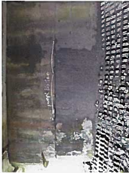
WL 1, STB 3, undicht mit Schlamm u. pumpt bis 1mm
