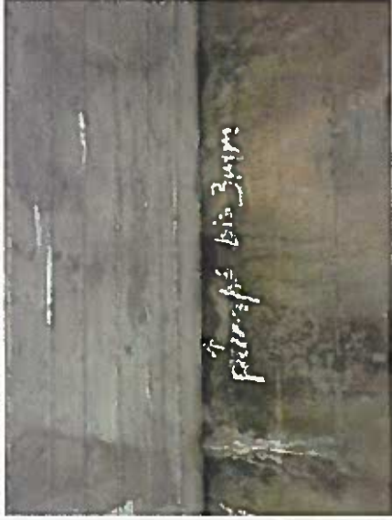
STB 2, Tragwerk pumpt bei Zugfahrt bis 3mm über WL 1+2
